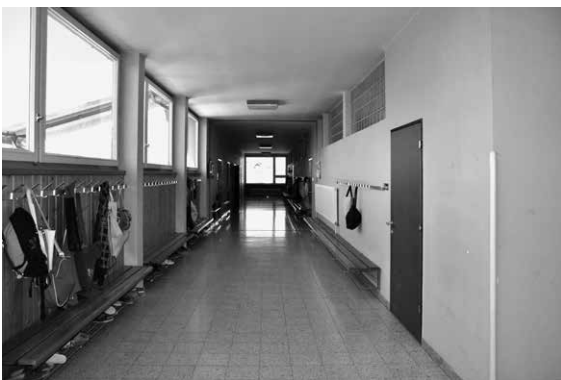
Klassentrakt vor dem Umbau
